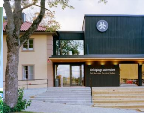
Malmstens Byggmästare John Mattsons Library
